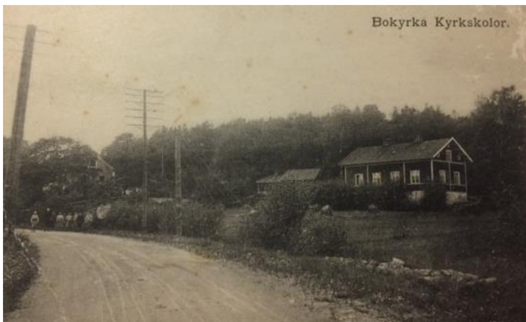
Bo Jonssons mamma Ingrid gick i Kyrkskolan, en byggnad som ligger mitt emot Botkyrka kyrka. (Kan det vara felstavat?? står Bokyrrka, borde vara Botkyrka). Byggnaden finns kvar än idag och tillhör kyrkan.
